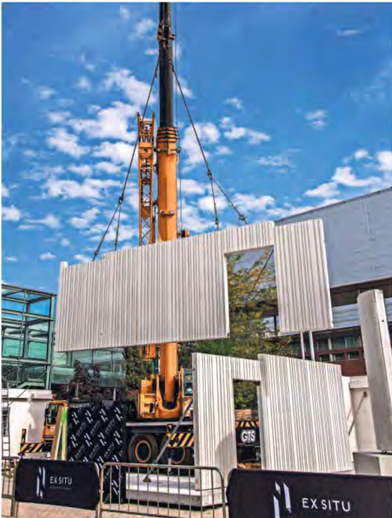
La firma Ex Situ levantó en la pasada feria Construtec un edificio de hormigón armado de tres plantas.
