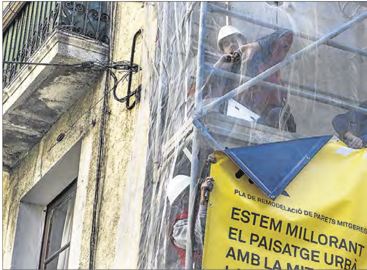
► Obras de rehabilitación en un edificio del Raval de Barcelona.
