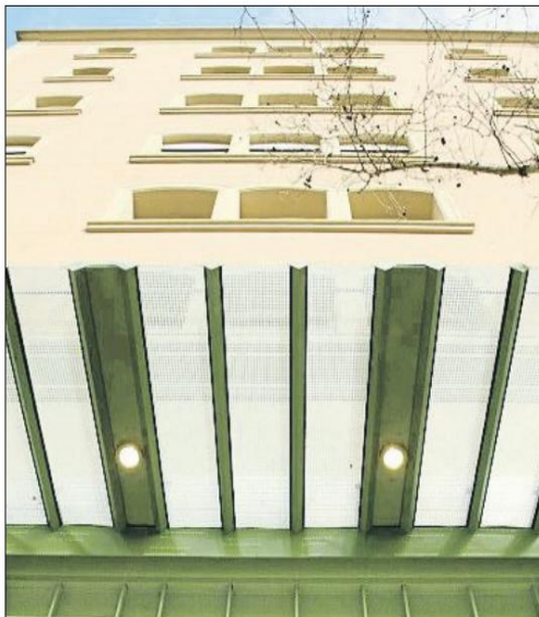
El Clínic, un hospital pendiente de la ampliación
