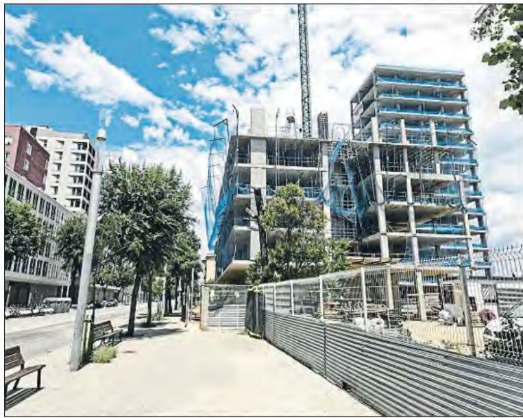
Terrenos de los antiguos cuarteles de Sant Andreu donde se construye vivienda libre y protegida
