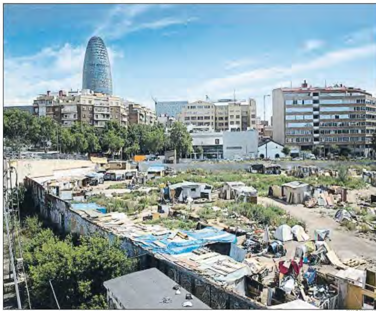
Asentamiento en la esquina de la calle Tànger con Àlaba
