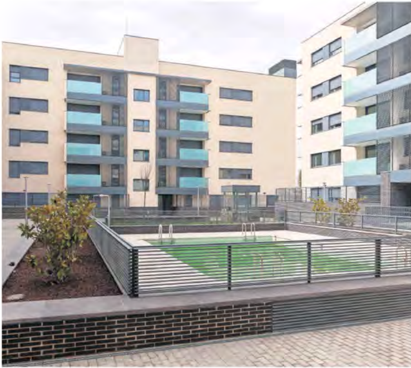
Promoción de pisos en alquiler construida por Aedas Homes para el fondo Ares en Torrejón de Ardoz (Madrid). NORA ZUBIA
