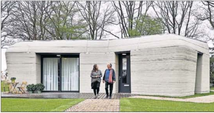
Primera casa habitada impresa en hormigón en 3D, en Bosrijk, Eindhoven. / BART VAN OVERBEEK
