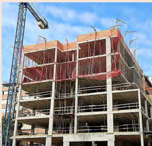
Vivienda en construcción en Barcelona.
